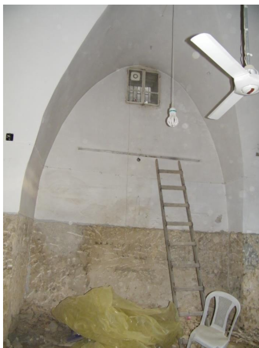
(لوحة ٧) مسجد القصير، الجزء الشرقي من الجدار الجنوبي بالحرم
