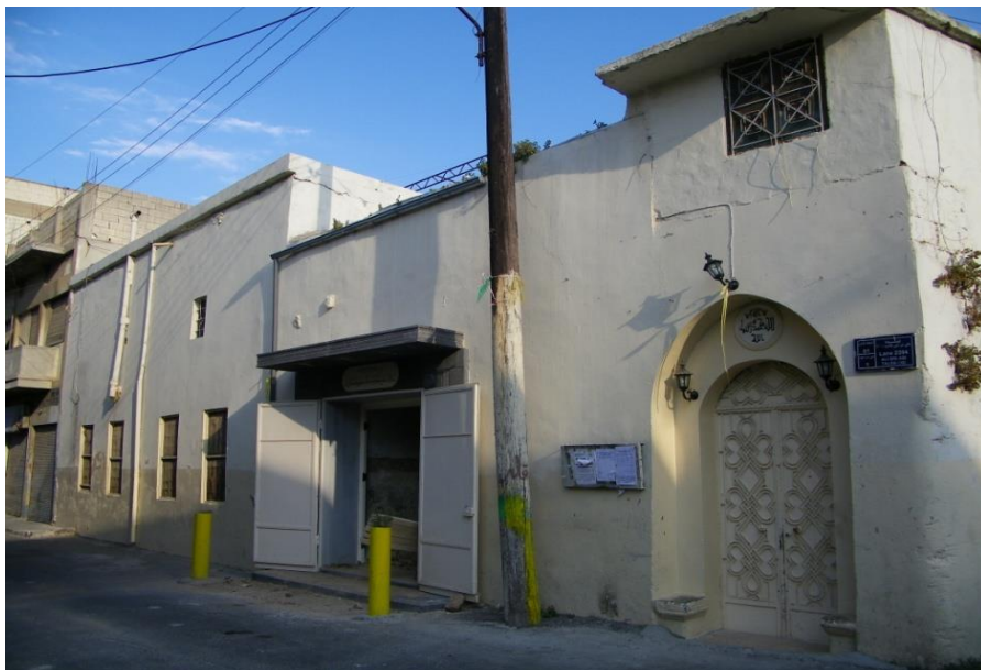
(لوحة ٢) مسجد القصير، الواجهة الشمالية
