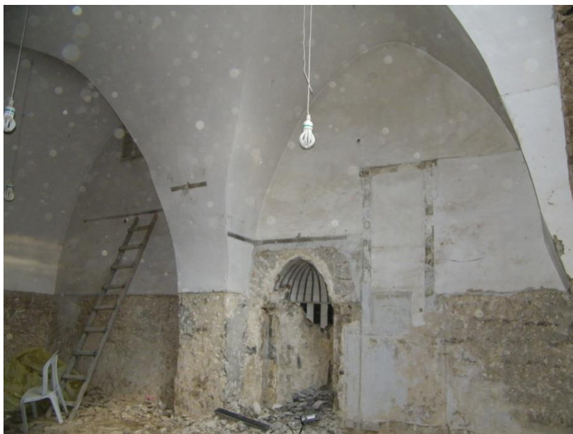
(لوحة ٥) مسجد القصير، الجزء الغربي من الجدار الجنوبي من الحرم
