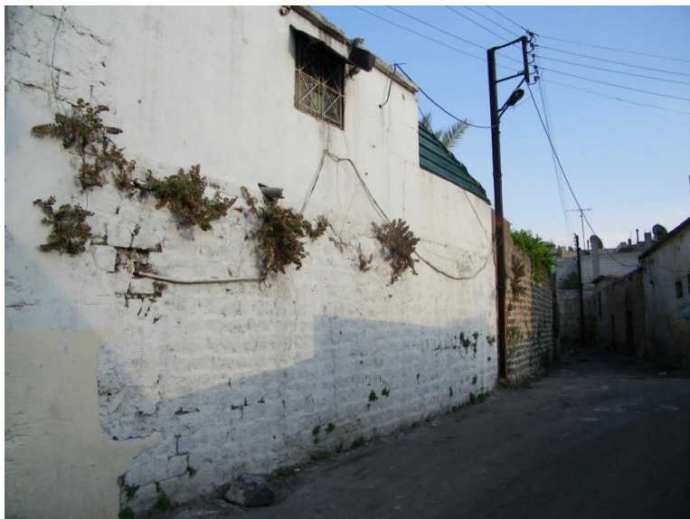
(لوحة ٤) مسجد القصير، الواجهة الغربية
