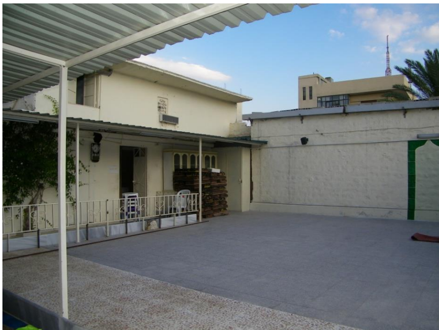
(لوحة ٢٣) مسجد القصير، واجهة الملحقات علي الصحن
